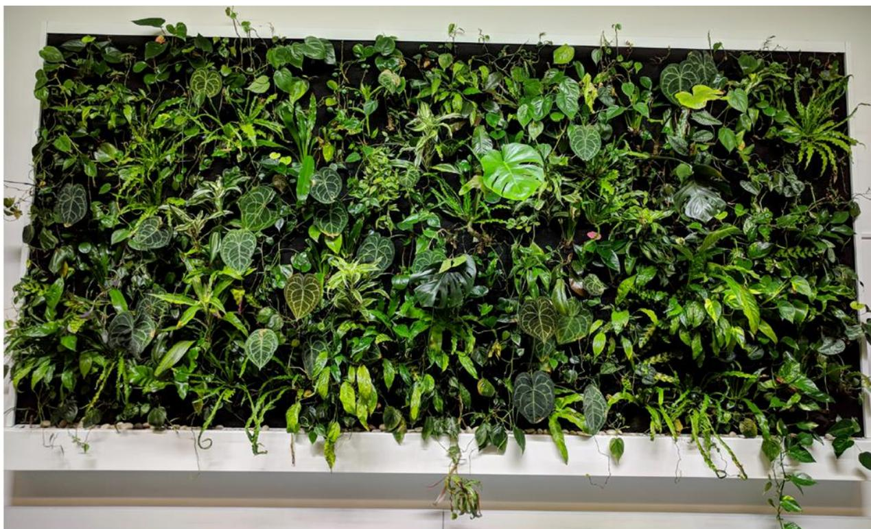
Abbildung 98: Vliessystem inklusive Bepflanzung am BRG 16 (Neubau ohne Lüftungsanlage) 05-2019.
