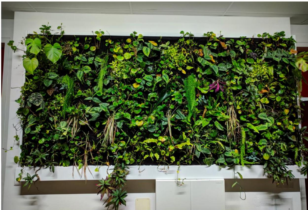
Abbildung 87: Vliessystem inklusive Bepflanzung im BRG 15 (Neubau mit Lüftungsanlage).05-2019.
