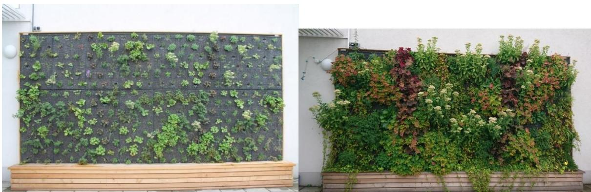
Abbildung 8: Kassettensystem am BRG 15 (Neubau mit Lüftungsanlage) Links: kurz nach der Bepflanzung im Sommer 2017; Rechts: 2 Jahre nach der Bepflanzung (Sommer 2019)
