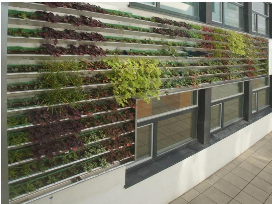
Abbildung 4: Trogsystem im Außenraum an der Fassade des BRG16 (Neubau ohne Lüftungsanlage)
